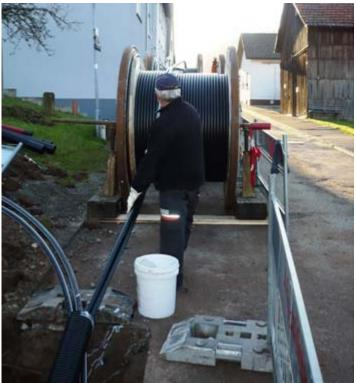
Dabei wurden die störungsanfälligen Überlandleitungen gekappt und durch sichere Erdkabel ersetzt – die Igelsbacher werden sich an weniger Stromausfälle gewöhnen müssen.
